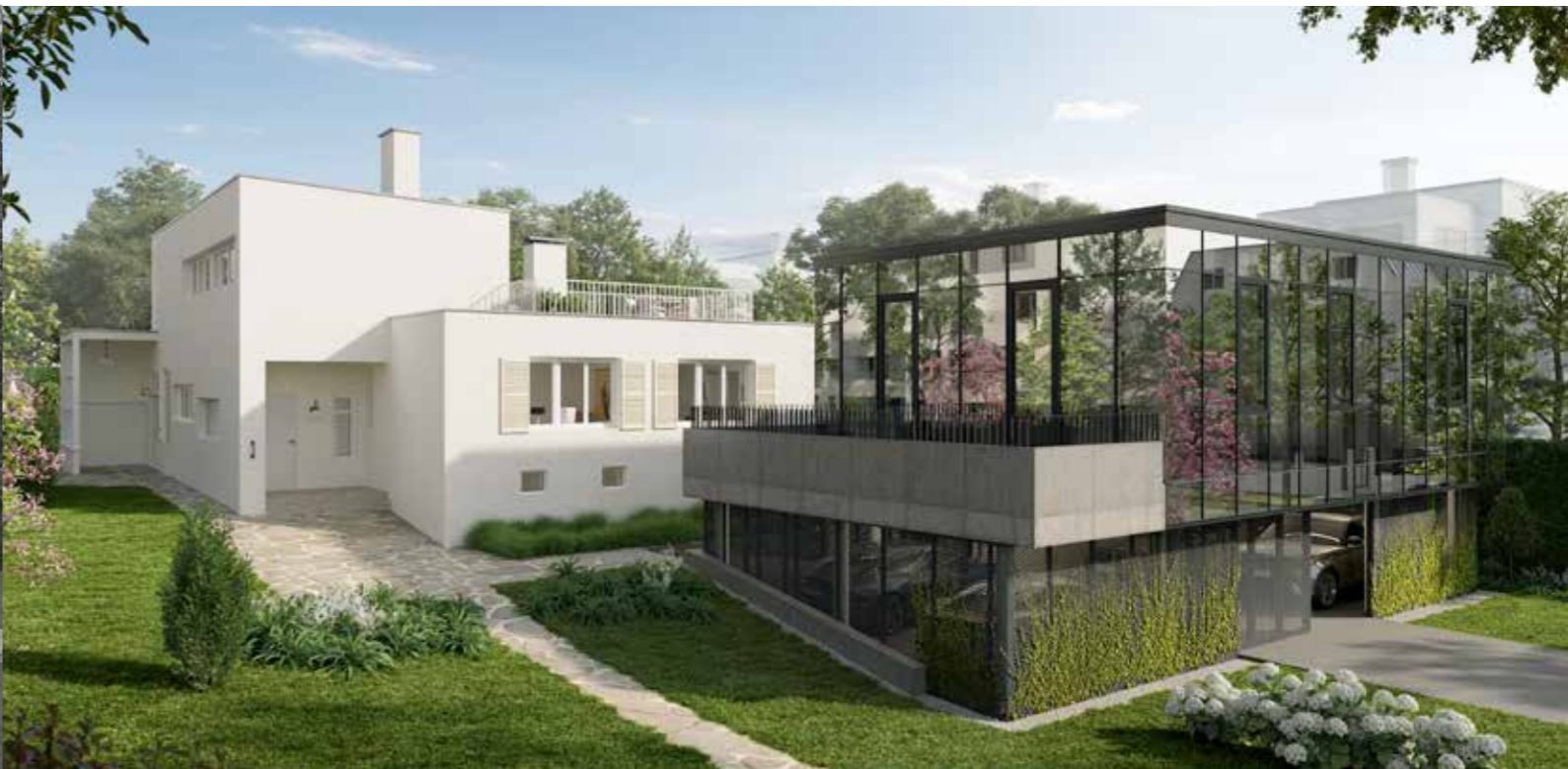
Fast 90 Jahre nach der Fertigstellung des Bauwerks präsentiert sich die Villa Bunzl heute in neuem Glanz – und einem vorgesetzten Baukörper, der Raum für neue Ideen schafft.
