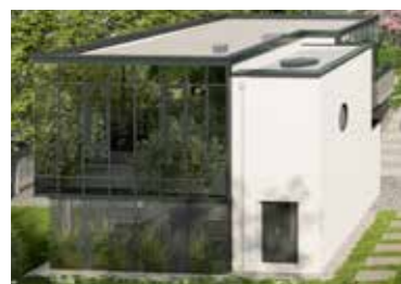
Ein kreisrunder Lichteinlass und ein ebensolches Fenster zitieren auch am von Architekt Martin Tröthan entworfenem Neubau die unverkennbare Bauhaus-Formensprache.
